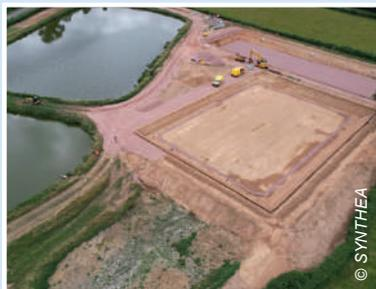
Vue aérienne d'un filtre vertical 2 étages en construction, associé à un lagunage
