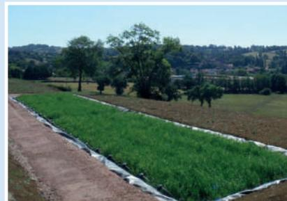
Vue du second étage d'un filtre vertical avec les roseaux en cours de développement
