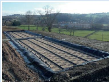
Vue du second étage d'un filtre vertical, avant pousse des roseaux
