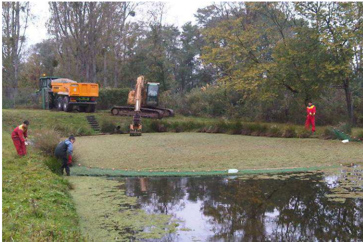
Raclage de surface et récupération au godet étanche
