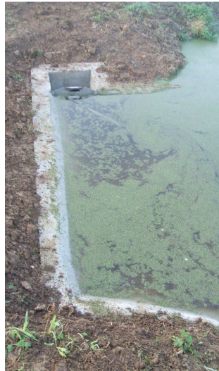
Pelle installée et fermée. Plan d'eau à sa cote normale.
