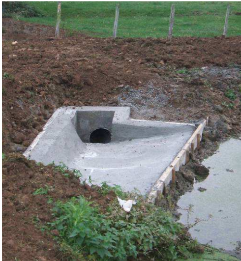
Seuil déversoir aménagé. Niveau du seuil sous la cote de rejet du lagunage (-5 cm) Un batardeau réglable serait un plus (-10 à -3 cm)
