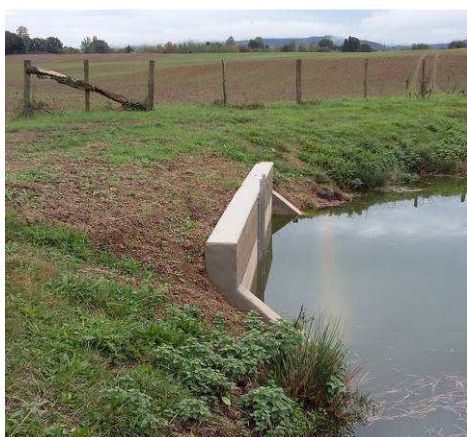
Muret béton épaisseur 20 cm et hauteur 1m avec pelle murale inox à poignée démontable
