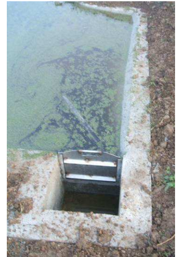
Pelle opérationnelle. Les lentilles sont évacuées
