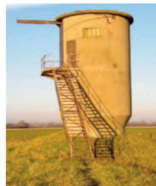
Puits de Toppes sur la commune de Charette Varennes
