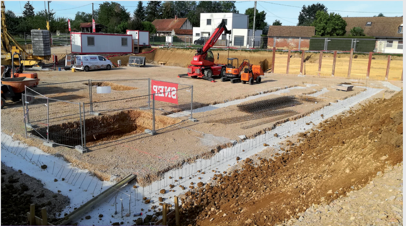
Chantier de l'EHPAD de Saint-Germain-du-Plain
