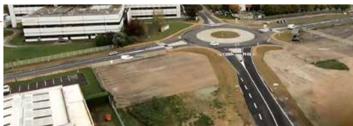
OUVERTURE DE LA RD819 QUI RELIE SAÔNEOR AU RÉSEAU ROUTIER (octobre)
